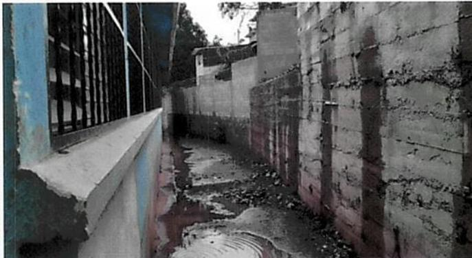
Otra parte del muro perimetral que se necesita la colocación de 5 hiladas de block y reubicación de reiser
