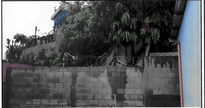
Parte frontal del muro donde se necesita ampliación de 5 hiladas de block y reubicación de reiser
